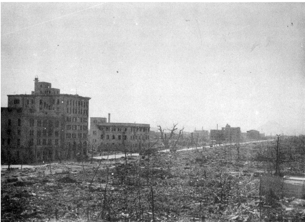
ABBILDUNG 10: INNENSTADT VON HIROSHIMA 1946 MIT GEBÄUDEN DER BANK OF JAPAN WO DIE ATOMBOMBE ANSCHEINEND EXPLODIERTE.
