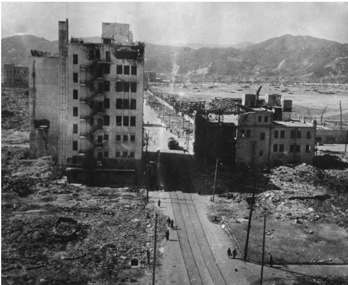
ABBILDUNG 12: GEBÄUDE IN DER RIJO DORI STREET IN DER INNENSTADT HIROSHIMAS WURDEN OFFENSICHTLICH NICHT VON DER DRUCKWELLE GETROFFEN
